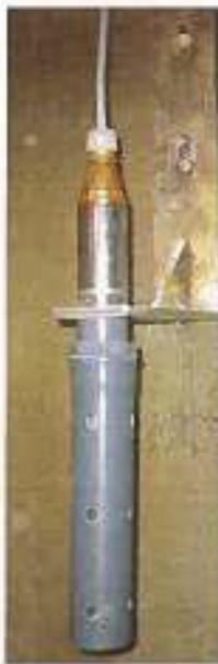
Las pruebas realizadas con **los modelos basados en paletas vibratorias** (Pruebas realizadas con la Sonda Endress & Hauser FTL31- Liquiphant T FTL260) han mostrado una gran fiabilidad en la medida. Como norma general su instalación se ubicará en una zona sin demasiadas turbulencias y cercana, en la medida de lo posible, al punto de alivio.
